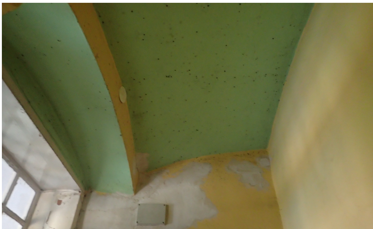
Fot. 7. Zagrybienia na suficie.
